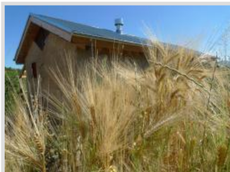
Realizzazione a Pescomaggiore (AQ) - EcoVillaggio Autocostruito EVA
